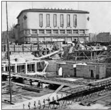
Ein Ort der Zwangsarbeit: Tiefbunkerbau unter dem Berliner Platz 1941.
